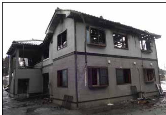
火災現場②
